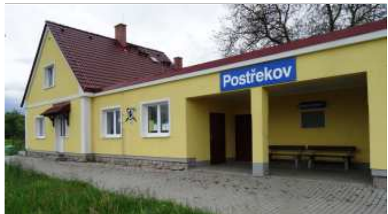
Jedna z opravených zastávek - Postřekov.
