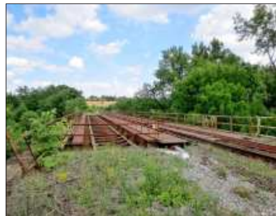
Pohled na kolejové lože původního dvojkolejného mostu u obce Železná. I zde byla jedna kolej snesena.
