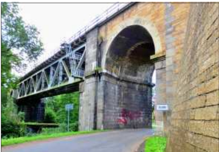
Při jízdě z Měcholup nalezneme u obce Železná železniční most, po kterém překonává železniční trať z Lužné u Rakovníka do Chomutova silnici a říčku Blšanku. Most je od roku 1958 registrovanou technickou památkou.
