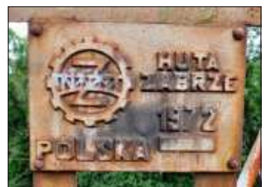
Tabulka, umístěná v konstrukci mostu, informuje o jeho poslední velké rekonstrukci.
