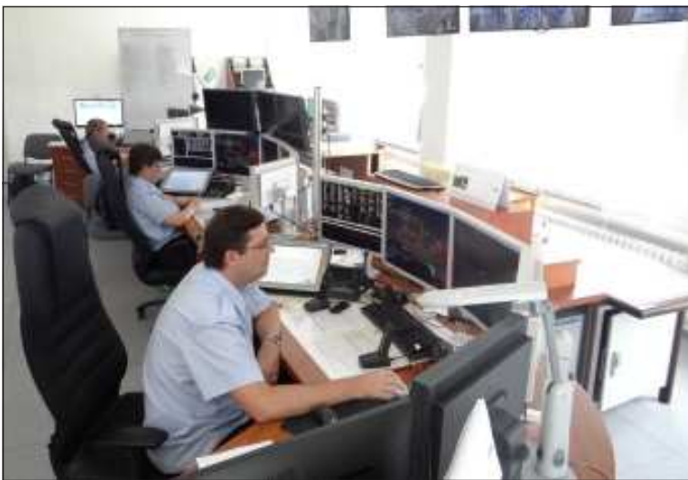
Nové zabezpečovací zařízení ESA 11 bylo v Břeclavi zprovozněno v roce 2016.
