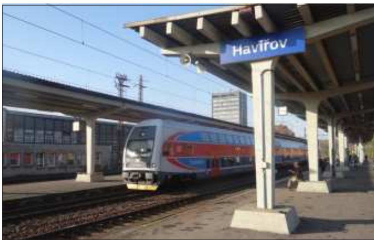
Havířovská nástupiště včetně podchodů projdou nutnou rekonstrukcí a modernizací.
