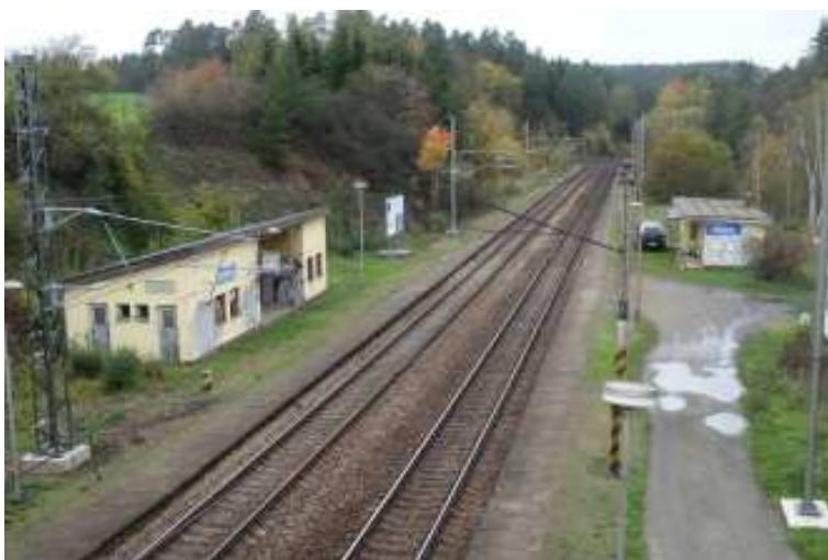
Cílem stavby je i rekonstrukce železniční zastávky Níhov.
