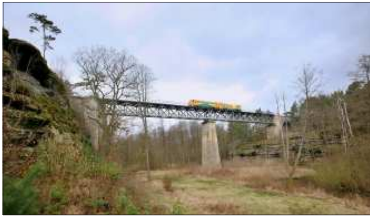
Po železničním mostě, klenoucím se ve výšce 24 metrů nad údolím Robečského potoka, přejíždí právě osobní vlak č. 6103 jedoucí z Postoloprta do České Lípy. Je sobota 3. 2., 11.20 hodin.
