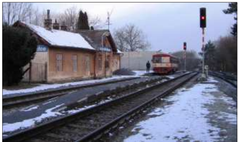
Os 25008 čeká na svolení k odjezdu v dálkové řízené žst. Kostelec u Heřmanova Městce, je porucha zabezpečovacího zařízení, tak pojede proti Stůj. U PZZ kvůli poruše stálo asi 30 aut. DOZ je v Heřmanově Městci. Budova nádraží je neobydlena. 20. 2. v 7.09 h.
