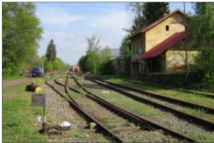
Zásmuky – mrtvé kolejíště a neojetá kolej k uhelným skladům, stav 24. 4.
