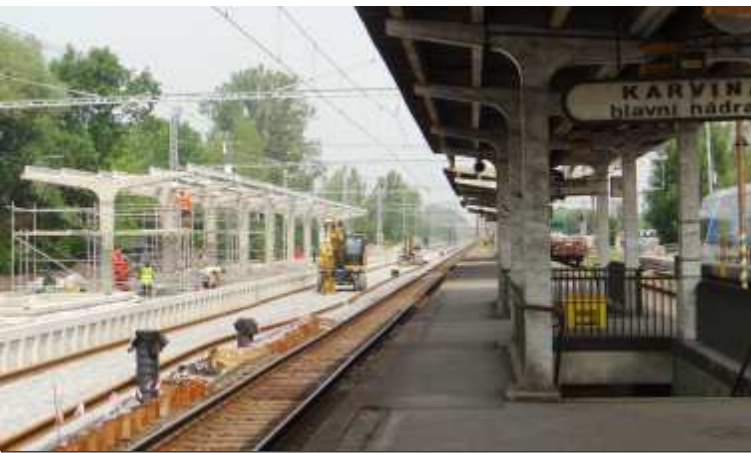
Současné s výlukou kolejí probíhá postupně i oprava nástupiště.
