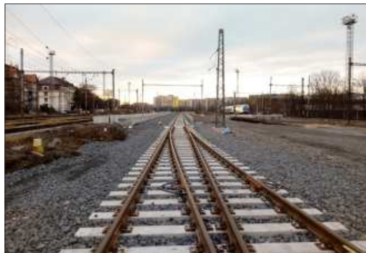
Budoucí zastávka Praha–Eden s odbočnou výhybkou směr nákladního Praha–Strašnice. Zcela vpravo vlak PID na staré trati. Stav 27. prosince 2018.
