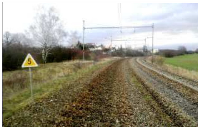
Původní hlavní trať SŽDC 170 Plzeň-Doubravka – Chrást u Plzně je nyní od km 100, 1 postupně likvidována kvůli nové přeložce přes tzv. Ejpovické tunely, vybudované v rámci optimalizace tratě Plzeň – Rokycany. Na snímku torzo staré trati se zachovalým předvěstníkem a dosud zatím existujícími sloupy trakčního vedení s branami u obce Druztová, jež se nachází na okraji přírodního parku Horní Berounka. Snímek z 30. 12. 2018.
