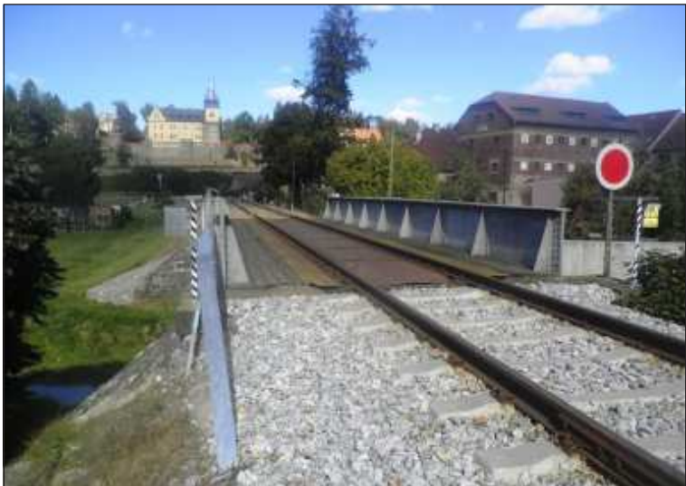
Dlouhodobá výluka traťové koleje v úseku Zruč nad Sázavou – Kácov započatá v roce 2017 začíná na železničním mostě přes Ostrovský potok ve Zručí n. S. V pozadí zručský zámek. Na fotografií je zachycen stav trati před započetím stavebních prací dne 29. 9. 2018.
