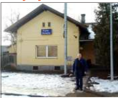
Dozorce výhybek SŽDC úseku Praha Braník – Dolní Břežany Jarov Bohumil Petřík je legendou Modřanky. Na snímku z 8. 2. před dopravní kanceláří Praha-Zbraslav.
