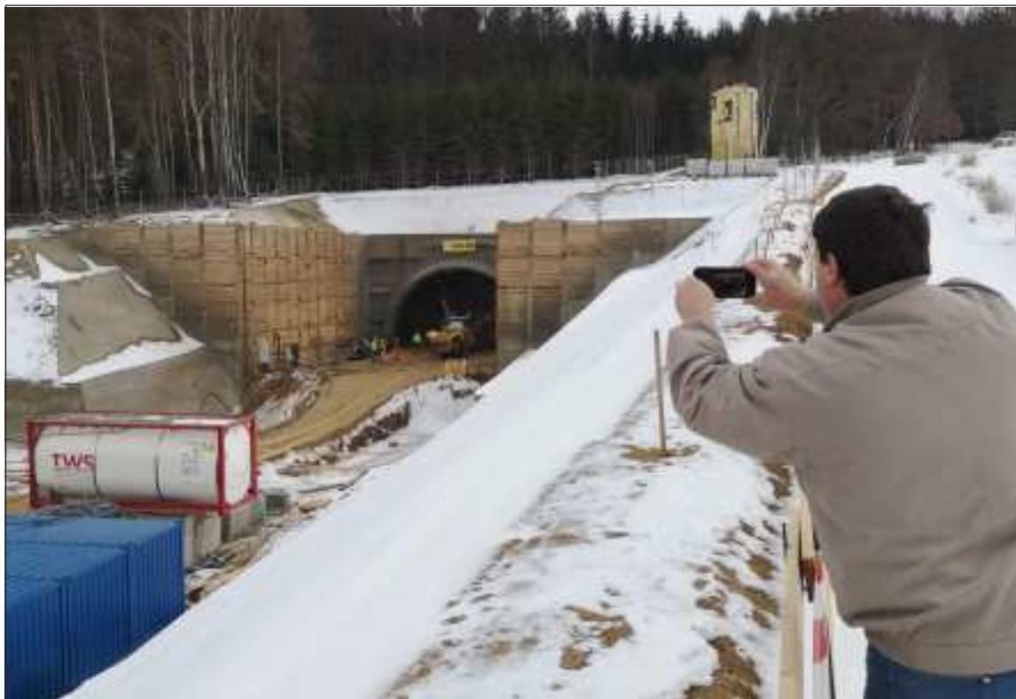
Nedaleko železniční stanice Ješetice razí zhotovitelská firma OHL ŽS nový tunel pod vrchem Deboreč. Ražba 660 metrů dlouhého dvoukolejného tunelu začala ve směru od výjezdového pražského portálu. Stavba byla slavnostně zahájena ve čtvrtek 13. prosince 2018, proražení tunelu je naplánováno na červenec příštího roku. Snímek Michael Mareš
