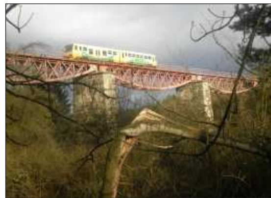
Regionální trať Chrást u Plzně – Radnice byla vybudována jako odbočka z České západní dráhy kvůli těžbě uhlí ve Stupně. Po ocelovém viaduktu o třech polích, jímž trať přechází údolí řeky Klavavy poblíž obce Chrást, projíždí MOs 17815 v relaci Radnice – Plzeň dne 30. 12. 2018. Pro tuto trať by jistě byl spíše vhodnější dopravní koncept spočívající ve vytvoření regionální vlakové linky Nezvěstice – Rokycany – Radnice s vloženými posilovými spoji v relaci Plzeň – Chrást (Radnice).
