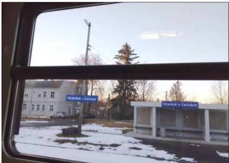
Hranice v Čechách – výpravní budovu nahradil betonový bunkr, vlevo opravený bývalý nádražní hotel, tak mohlo vypadat i nádraží, kdyby se lidé uměli dohodnout, co vlastně chtějí.
