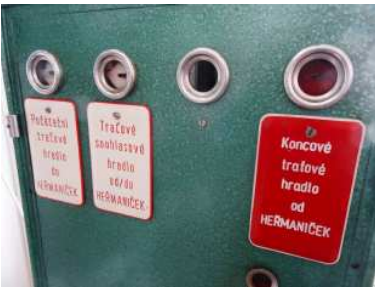
Hradlový blok zajišťující závislost mezi elektromechanickým zabezpečovacím zařízením žst. Heřmanický a reléovým zabezpečovacím zařízením TEST v Ješetích vstoupí za necelé tři roky do historie.
