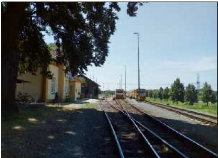
Křižování v Sudoměřicích nad Moravou (trať 343), Os 2738/2713, 26. 6., 12.34 h.
