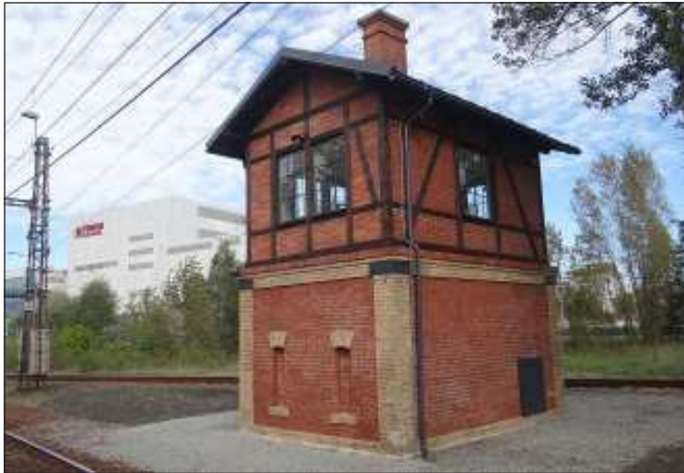
Opravené původní hrázdečné stavědlo v železniční stanici Ostrava střed. V pozadí bývalý areál koksovny Karolina, dnes nákupní centrum Nová Karolina.
