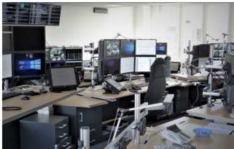
Dopravní kancelář železniční stanice Brno hl. n. týden před spuštěním do „ostrého“ provozu.
