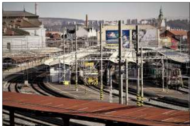
Pohled na brněnské nástupiště z nové provozní budovy SZDC.
