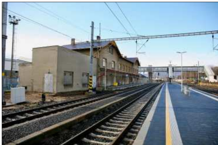
Pohled na nové ostrovní nástupiště v železniční stanici Řetenice, kde nezástával doslova kámen na kameni. Půjde stávající nádražní budova nakonec k zemi?
