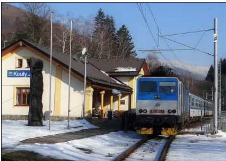
Budova železniční stanice Kouty nad Desnou slouží převážně jako útulek vlakových a lokomotivních čet.
