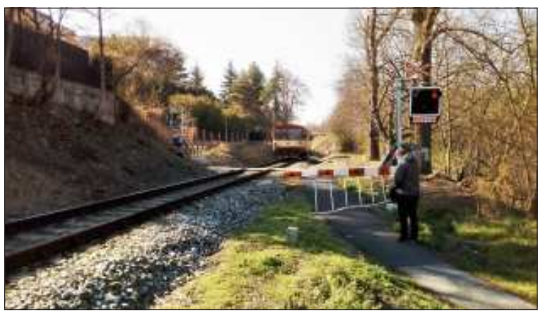
Zastávka Praha–Konvárka ležela v km 6,6, vede k ní přístupová cesta, která spojuje ulice Pod Děvinem a U Divčích hradů, je zabezpečena PZZ v km 6,545 (P 2191) se závorami (typ PZZ–RE PZS 3 ZBI), kolem zastávky je velká vilová čtvrt.
