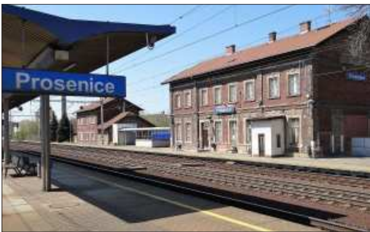
Budova železniční stanice Prosenice stojí na svém místě již přes 120 let. V současné době je opuštěná.
