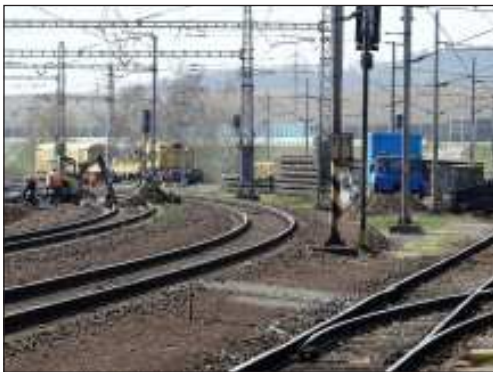
Na dluhonické zhlaví železniční stanice probíhaly v průběhu dubna práce na montáži unikátní dvojice výhybek.
