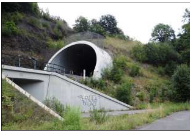
Hněvkovský tunel I byl zprovozněn v roce 2006 v rámci narovnaní tratě, klikatící se údolím Moravské Sázavy.
