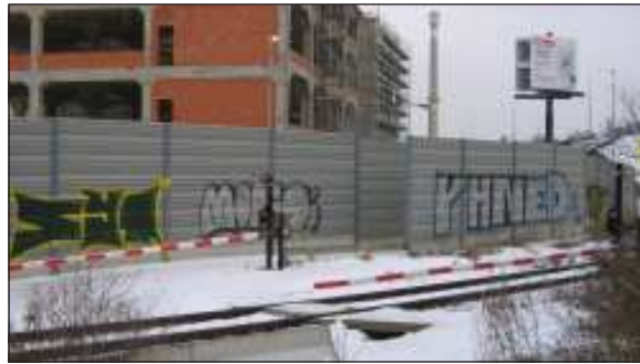
Závory v obvodu žst. Praha-Jinonice má obsluhovat hláskař. Zajímalo by mě, jak to provede, když z přejezdu chybí drátovaya a pohon, závory navíc končí v protihlukové zdi s průchodem pouze pro chodce; ale uznejte, nejsou krásně zrekonstruované?... Snímek ze 17. 1. 2017.
