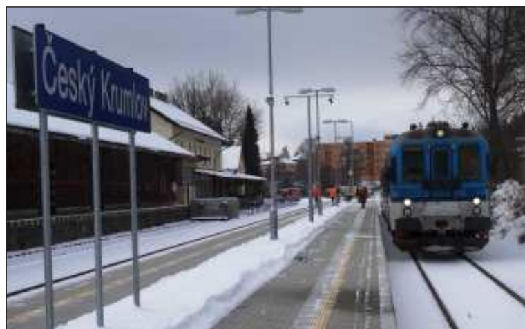
Upravené přístupové cesty a zvýšené ostrovní nástupiště učinily z Českého Krumlova doslova koridorovou stanicí.
