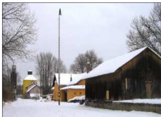
Budova n.z. Polná je nově opravena a obydlena, v pozadí továrnička AGP Biodiesel.
