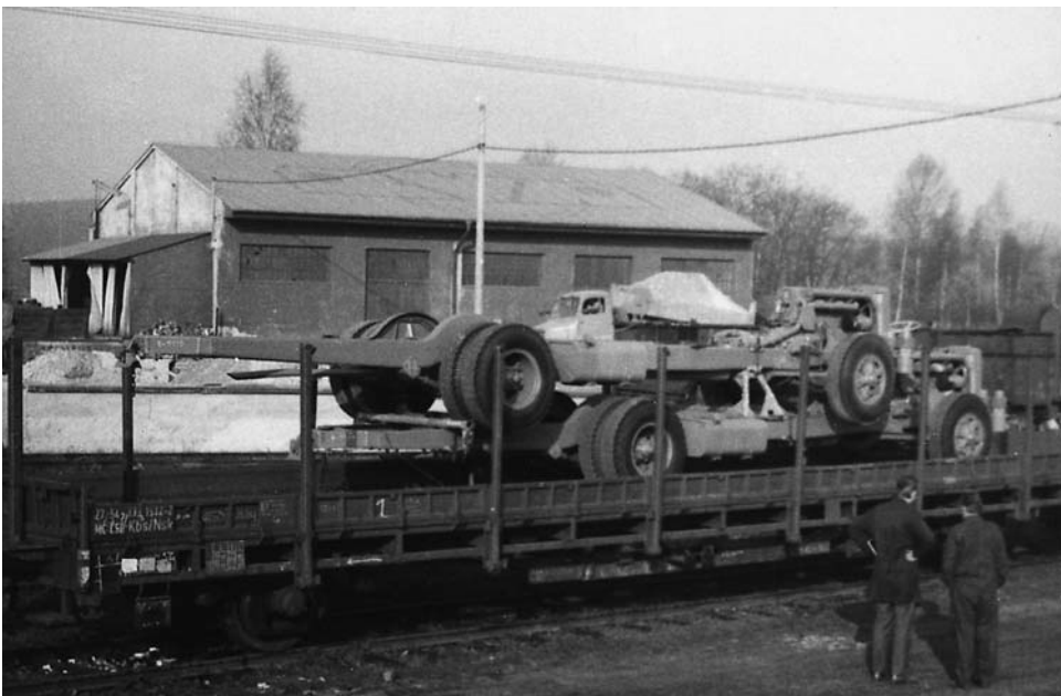
Na vlečce SVA Holýšov probíhaly zátěžové zkoušky pro přepravu podvozků autobusů na železničních vozzech. FOTO: ARCHIV DOMU DĚJIN HOLÝŠOVSKA
