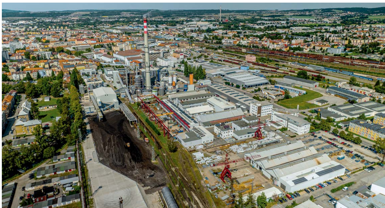
Letecký pohled na areál teplárny v Českých Budějovicích. Na hlubinném zásobníku právě probíhá vykládka uhlí z železničních vozů. V pozadí je vidět komín výtopny Vráto. FOTO: TČB
