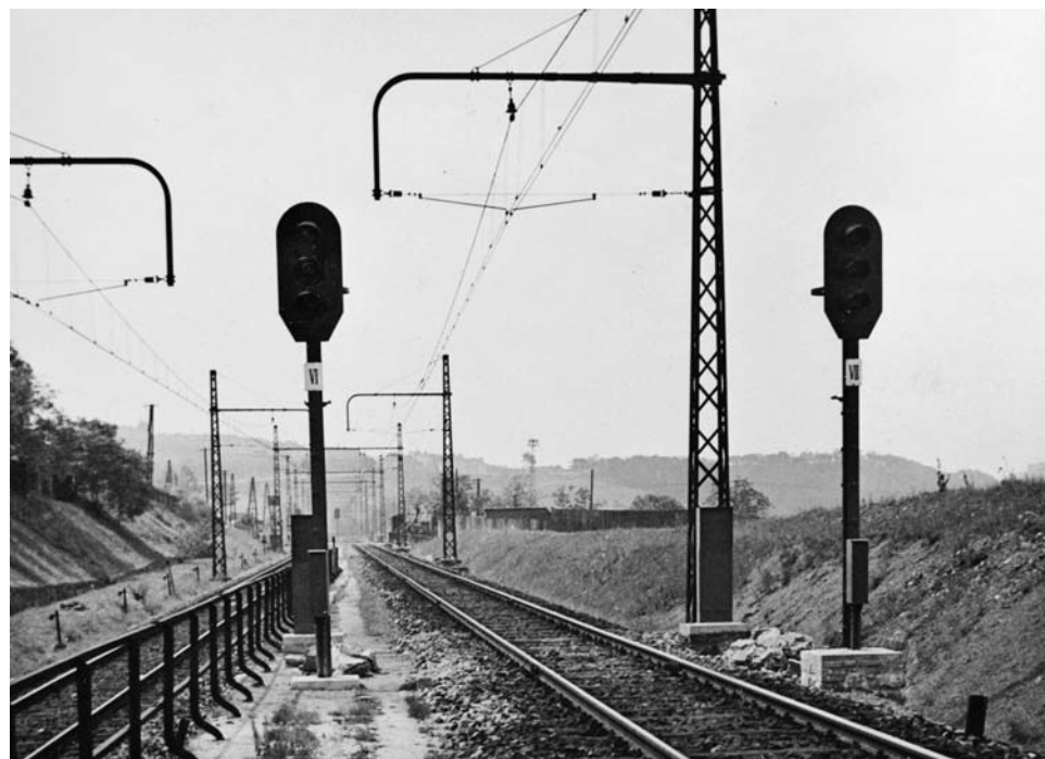
Trakční vedení ČMK/ČKD ve výhybně Vítkov, včetně vjezdových světelných návěstidel, prvních na síti ČSD
