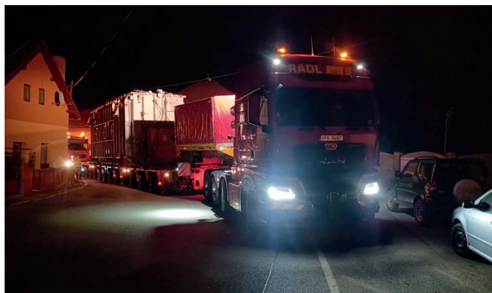
Noční přesun transformátoru do rozvodny Neznášov
