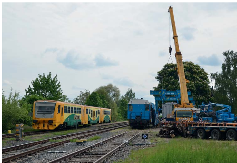
Překládka transformátoru přinesla mírné omezení osobní dopravy ve stanici Všestary.
