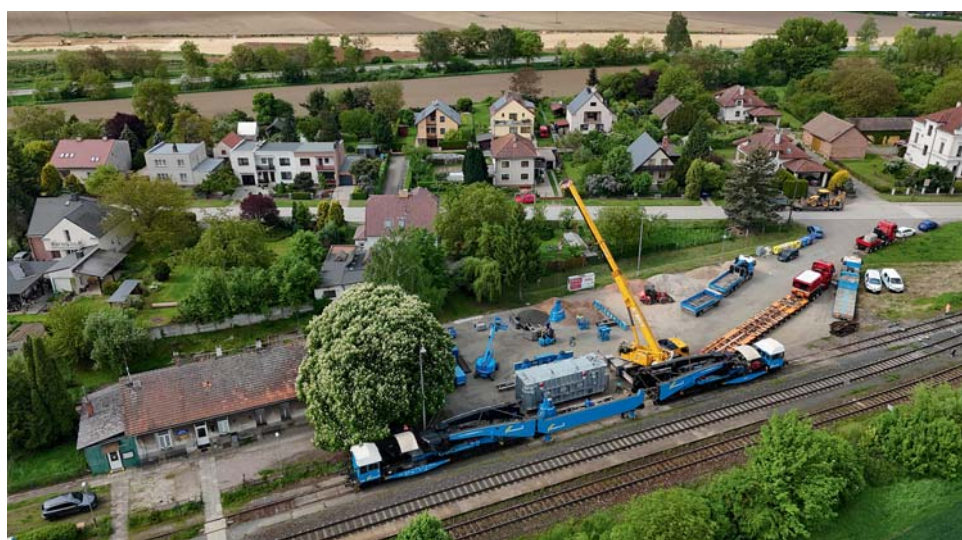
Celkový pohled na místo překládky ve stanici Všestary
