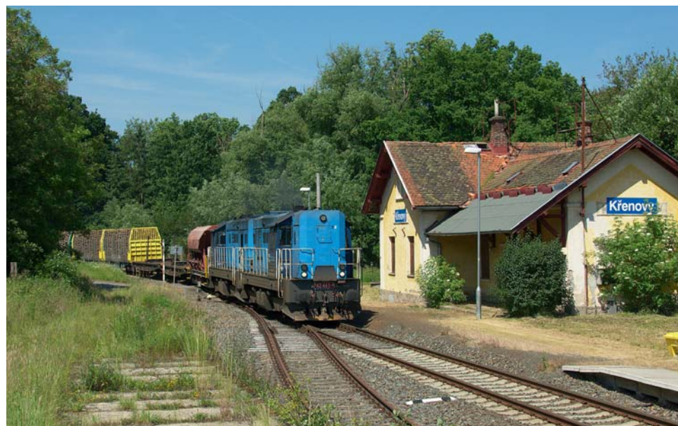
Téměř archaická stanička Křenovy, kde je obnoveno kolejiště, a to včetně manipulační koleje.
