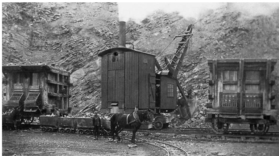
Těžba vápence v původním lomu v Kosově. Bagr těžil do zásobníků, ze kterých byl vápenec nakládán do vozíků lanovky. Ty byly na podvozcích přistavovány do stanice lanové dráhy k zavěšení na lano (kolem roku 1910).
