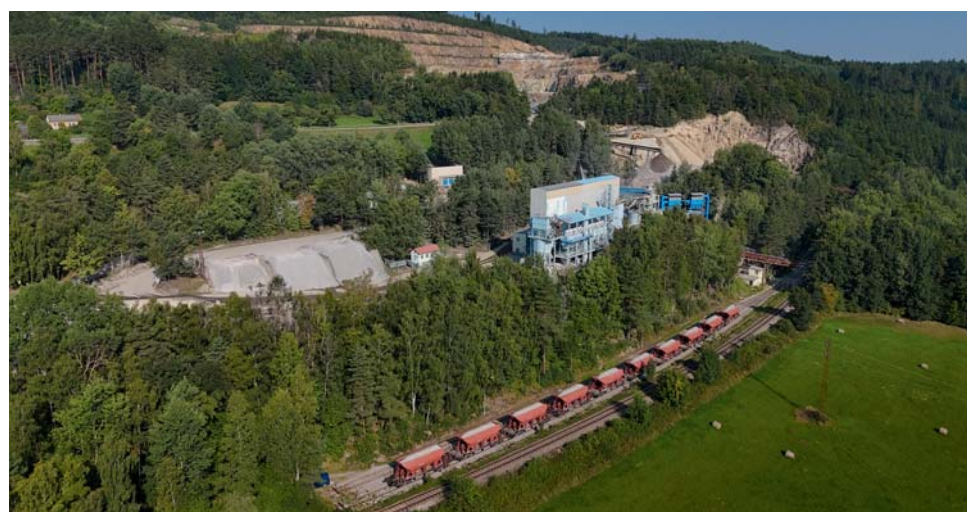
Celkový pohled na lom Plešovice s železniční vlečkou FOTO: MICHAL ROH
