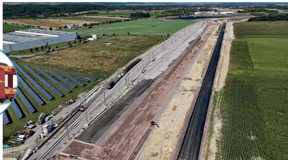
Rozestavěná seřadovací stanice Lipovka
