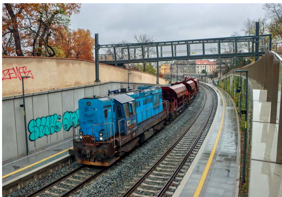
Dosypávání štěrku v nové stanici Praha-Výstaviště probíhalo mimo jiné i v neděli 9. listopadu 2025.
