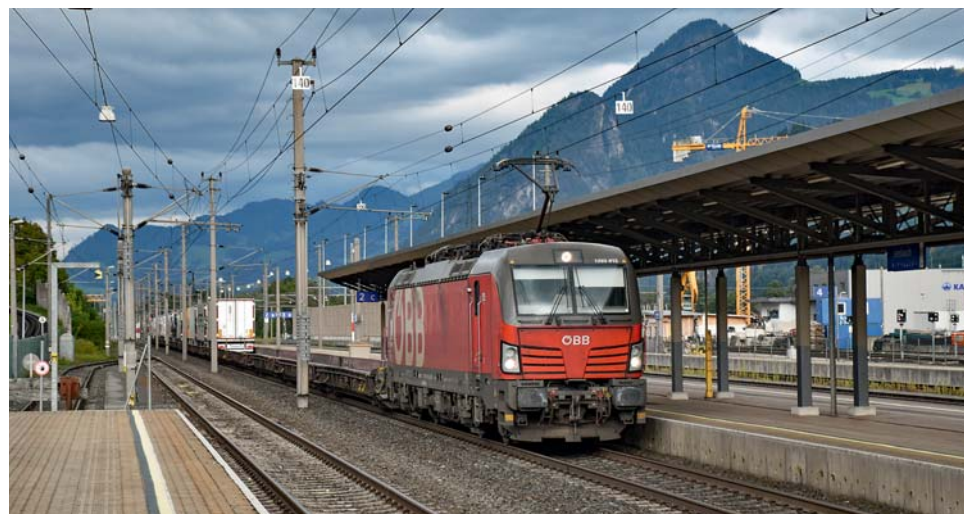
Po dokončení vysokorychlostní tunelové tratě patří hlavní trať přes Jenbach především regionálním osobním vlakům a nákladní dopravě. FOTO: MICHAL ROH ML.
