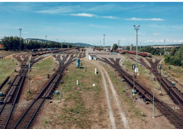
Od prosincové změny byly redukovány vlakové práce v málo vytížených seřadovacích stanicích.
