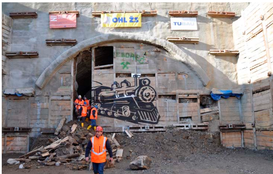
Proražení tunel Debořeč
