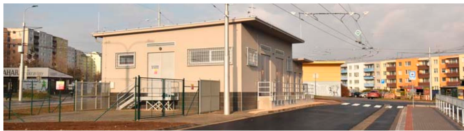
Budova měnirny Jírova
