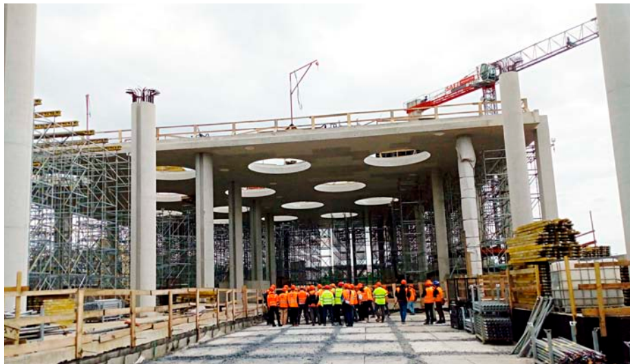
Výstavba nového vestibulu nádraží Praha-Bubny
