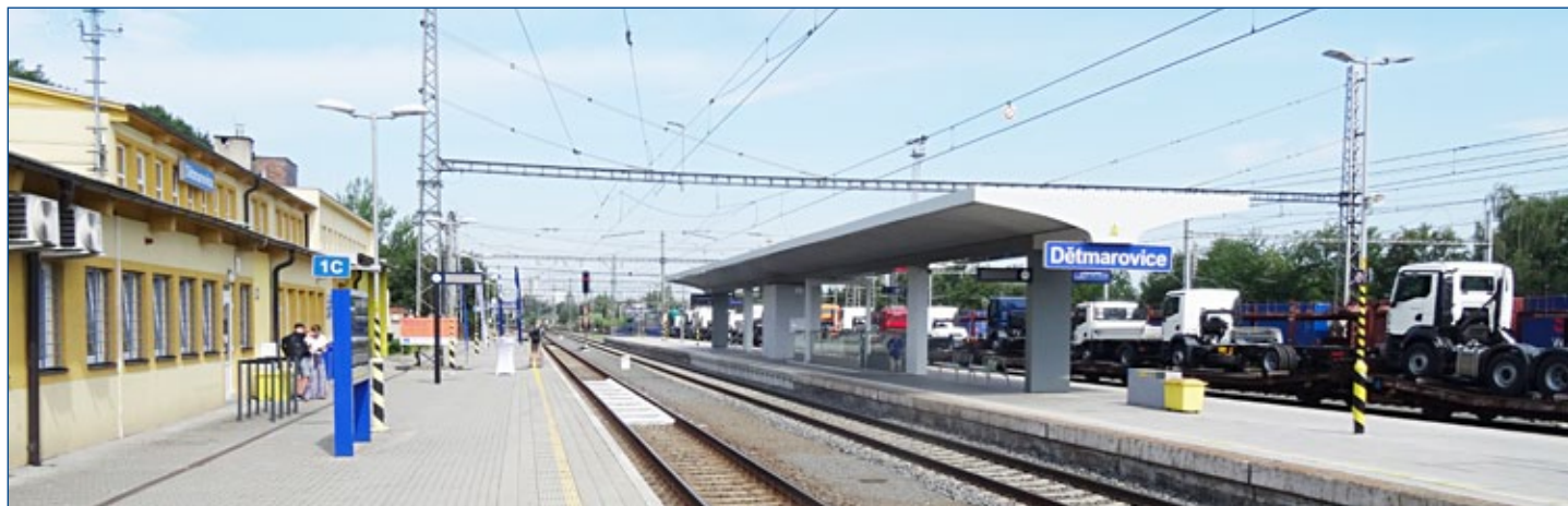
Rekonstruovaná železniční stanice Dětmarovice
