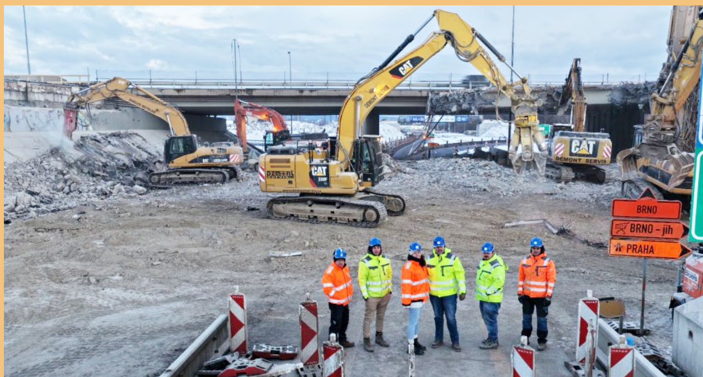
Stavba mimoúrovňové křižovatky D1 a D2, na které se aktivně podílí i společnost OHLA ŽS, pokračuje podle nastaveného harmonogramu. Pro plánovanou demolici mostu na dálnici D1 musela být po určitou dobu zcela uzavřena dálnice D2, kterou most křižoval. I přes mrazivé počasí se demolice zdárně podařila.
