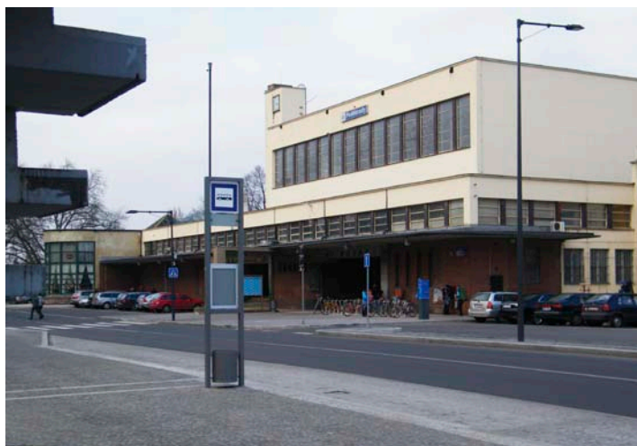
Budova nádraží, kterou čeká rozsáhlá oprava
