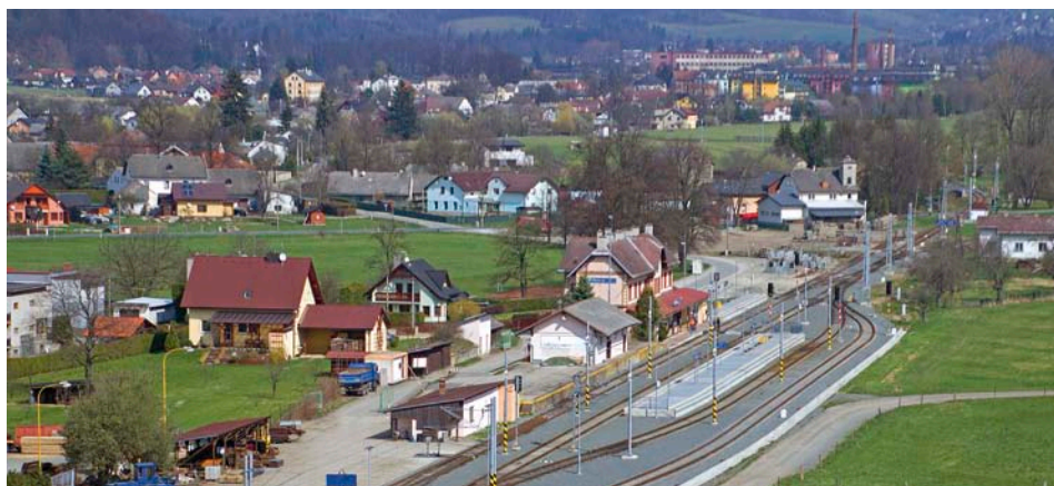
V současné době byla dokončena elektrizace tratě Šumperk–Kouty nad Desnou, kterou prováděla akciová společnost Elektrizace železnic. Na nímku Tomáše Prokopa železniční stanice Petrov n. D.
