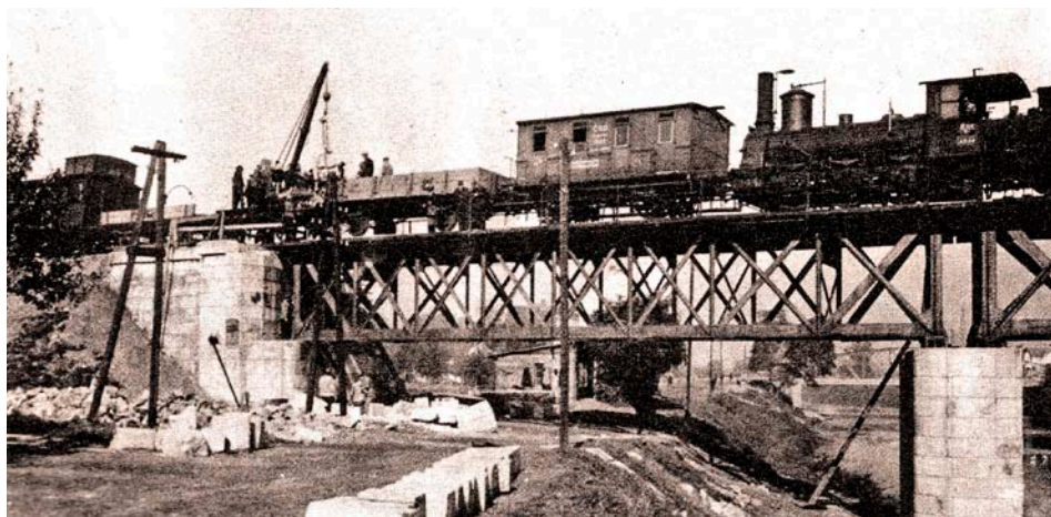
Stavba mostu přes řeku Svratku
