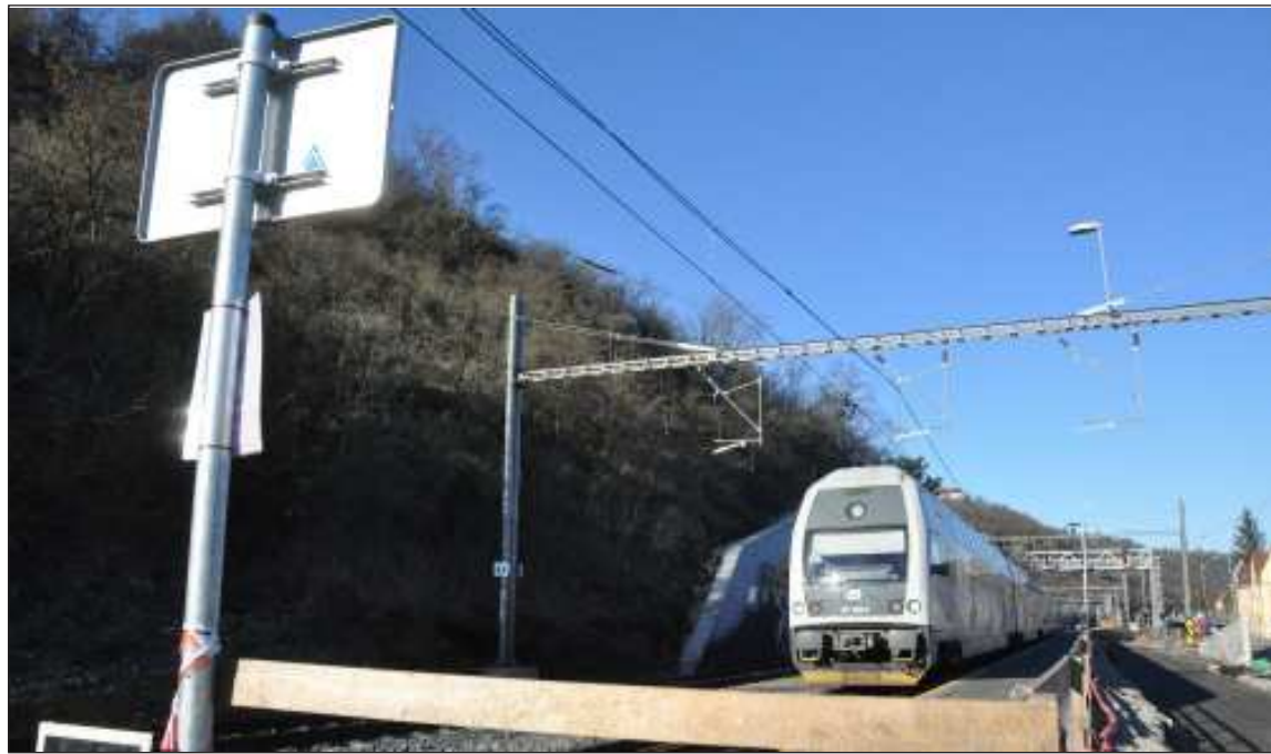
Od 15. října loňského roku je v Praze ve Velké Chuchli v provozu provizorní nástupiště dlouhé 100 m u koleje č. 2 v blízkosti železničního přejezdu. K otevření nových nástupišť dojde 1. 3. 2022 (pro směr Beroun), respektive 30. 6. 2022 pro směr Praha. Na snímku Michaela Mareše osobní vlak 8840 v pátek 14. 1. 2022. zastavuje v Praze Velké Chuchli.
