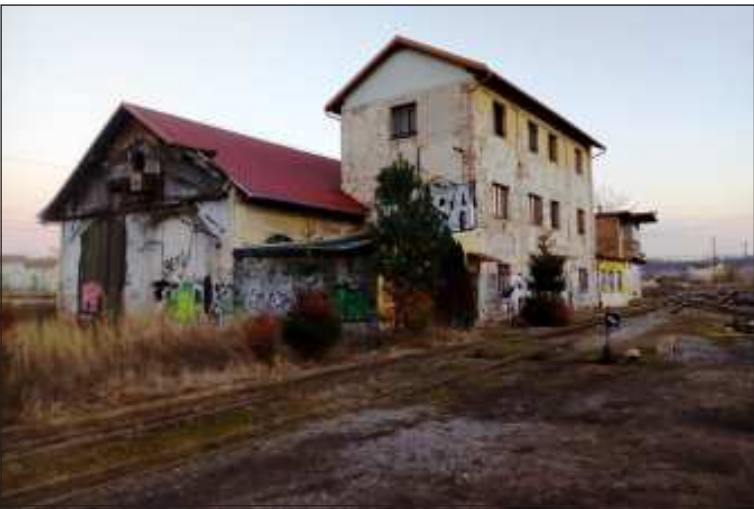
Až byla nedávno na objektech druhy Buštěhradské dráhy v Bubnech obnovena střecha a štítový objekt v současnosti chátrá. Turecké hospodářství v ČR, stav 15. 1. 2022.
