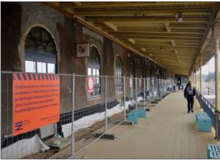
Z krytého nástupiště je v současné době přístup pouze k osobní pokladně, vše ostatní je uzavřené.
