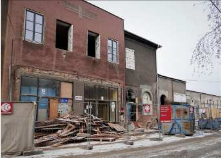
Celé opavské západní nádraží je v současné době jedno velké staveniště. Na úpravy čeká i přednádražní prostor.
