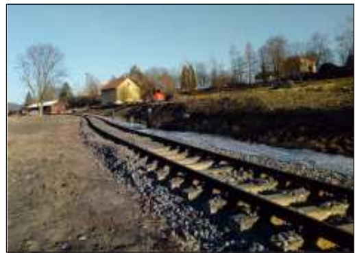
Po 44 letech obnovená spojovací trať mezi dolním a horním nádražím v Úštěku, stav 8. 3., v den MDŽ.
