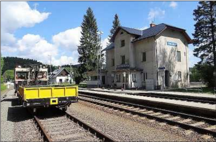
Budova železniční stanice Ostružná projde v následujících měsících generální opravou.
