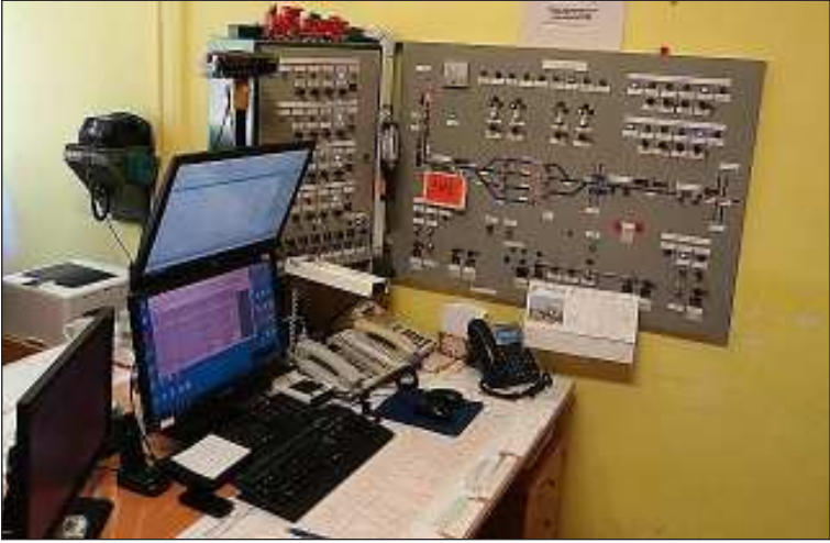
Provoz na trati a ve stanici je zajišťován za pomoci zabezpečovacího zařízení TEST.
