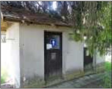
Dosavadní záchodky budou zbourány a nahrazeny novými uvnitř výpravní budovy.
