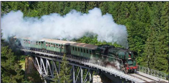
Parní vlak na čele s lokomotivou 464.202 Rosnička se soupravou Rybáků projíždí po mostě přes údolí Jizery mezi stanicí Kořenov a Harrachovem
