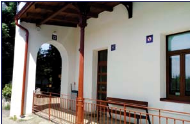
Jen malý piktoqram upozorňuje v žst. Jedlová na nádražku, někdo může nabýt dojmu, že zde hostinec již také není. Správa železnic prý zakazuje větší reklamy (tzv. kolečka na pivo, co tam točí) na nádražky směrem do kolejíště!
