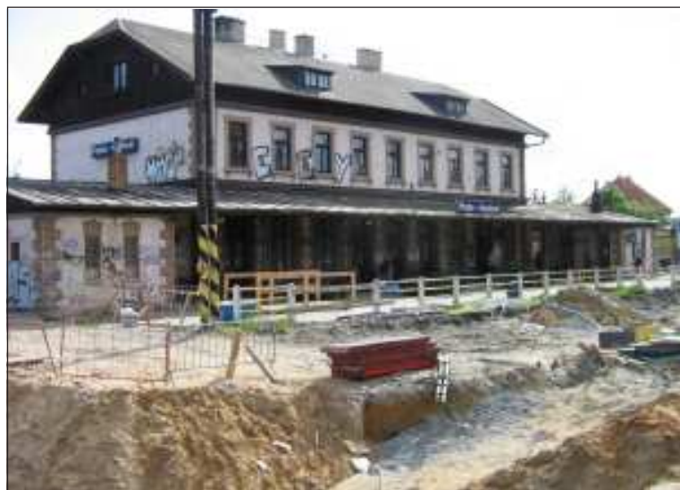
Vybagrovaný prostor v žst. Praha–Hostivař, stav 7. 5. 2015.
