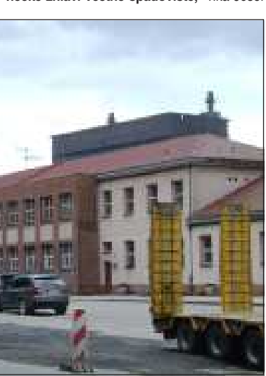
Současná podoba železniční stanice Třinec. Vyvýšená bytová část bude v průběhu přestavby zbourána.
