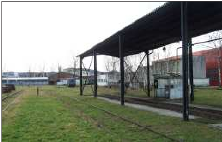
Celkový pohled na areál krnovského depa. Vlevo rotunda, zcela vpravo provozní budova KOS Krnov.
