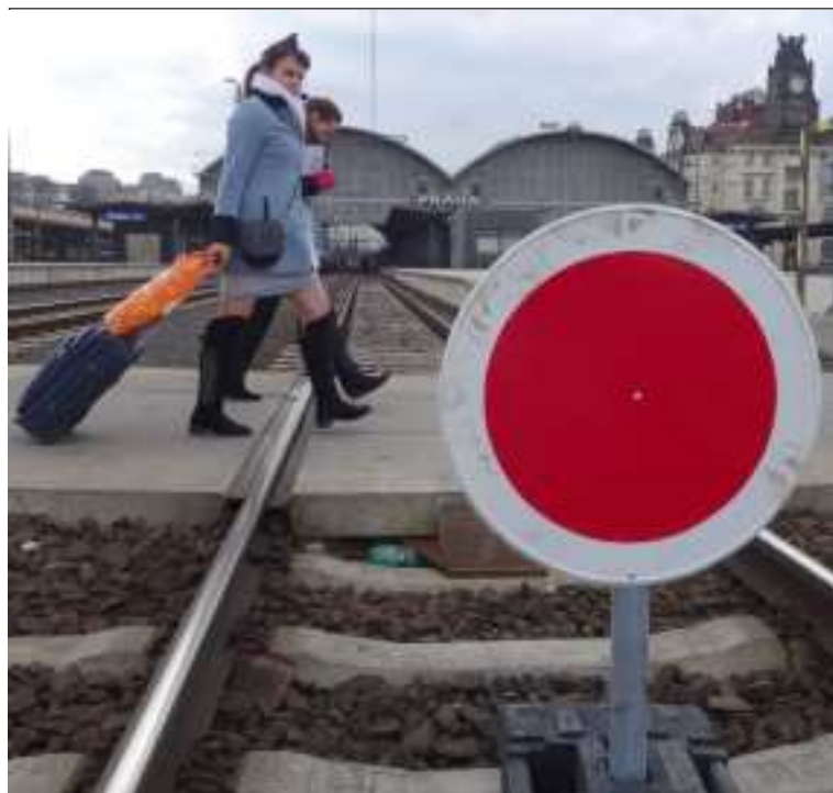
První etapa rekonstrukce pražského hlavního nádraží bude trvat celkem 63 dnů a během ní dojde k opravě sloupů na třetím nástupišti; z toho důvodu je třetí nástupiště až do 5. dubna 2015 uzavřené. Snímek Michael Mareš
