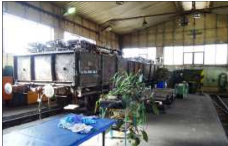
Zadní stěna haly podúrovňového soustruhu v SOKV Ústí nad Labem bude probourána a hala kolejově propojena se sousední halou, v níž je kolejová váha.
