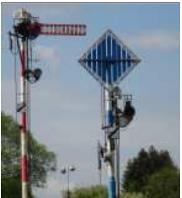
Po dokončení modernizace železniční stanice Janovice nad Úhlavou přijde o práci sedm signalistů a tři výpravčí.
