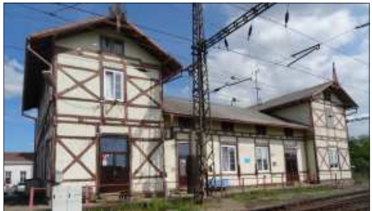
Půvabný původní objekt na chomutovském ranžíru pochází z roku 1872, v současné době jej využívá především společnost ČD Cargo a v dopravní kanceláři sídlí výpravčí SŽDC. Tl ze k 30. 6. 2015 skončí.
