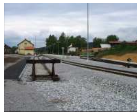
Černá v Pošumaví, stav kolejí 27. 5., vlečka na pilu byla sice do nového kolejí zapojena, ale vlečka je již léta „mrtvá“ a zbylá nakládka dřeva se odehrávala na VNVK, z níž nyní zbyla pouze kusá kolej, kam se vejdou sotva čtyři vozy.
