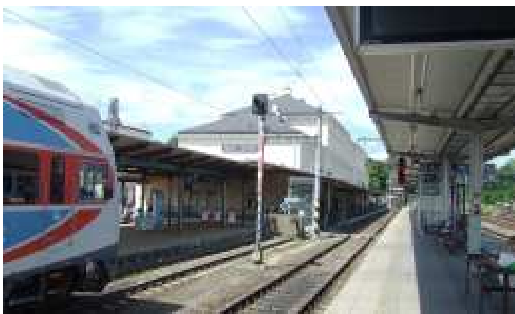
Všechny koleje na nádraží Opava-východ mají kusé ukončení. Elektrické vlaky, vedené soupravami Elefant, jezdí pouze v trati Opava-východ – Ostrava-Svinov.
