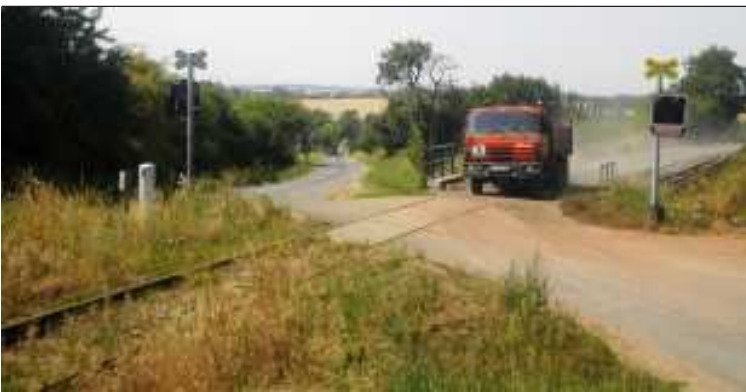
V současné době se rozběhly stavební práce na opravě poškozeného železničního náspu u tratového úseku Svojetín – Mutějovice. Těleso trati v dotčeném místě tak dočasně slouží k pohybu nákladních aut a stavebních strojů.
