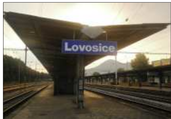
Unikátní reléové zabezpečovací zařízení bude při rekonstrukci žst. Lovosice nahrazeno moderní „jokou“.
