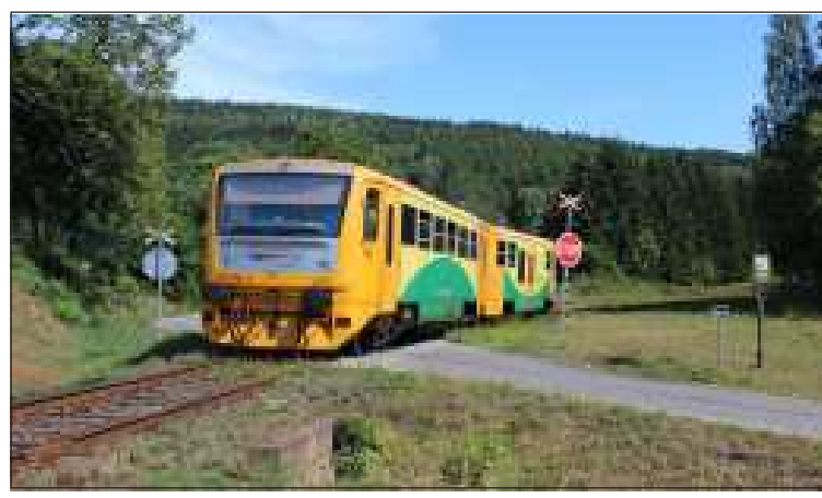
I přejezd v Chvalčovicích dostane nové přejezdové zabezpečovací zařízení.
